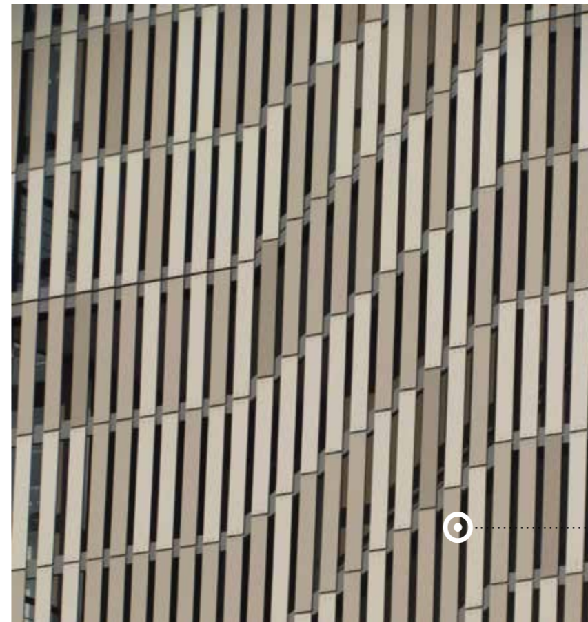
Edificio Vitra | Santiago | Chile
